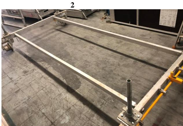
**Séquencement Montage Echafaudage sur LORRY (les roulettes ne sont pas à monter, mais à monter sur le LORRY)**
